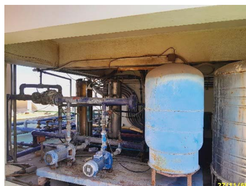
ถังสำรองน้ำชั้นดาดฟ้า Booster Pump อาคาร B
